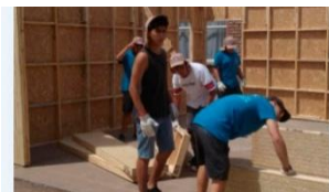
Trabajos de verano 2019
